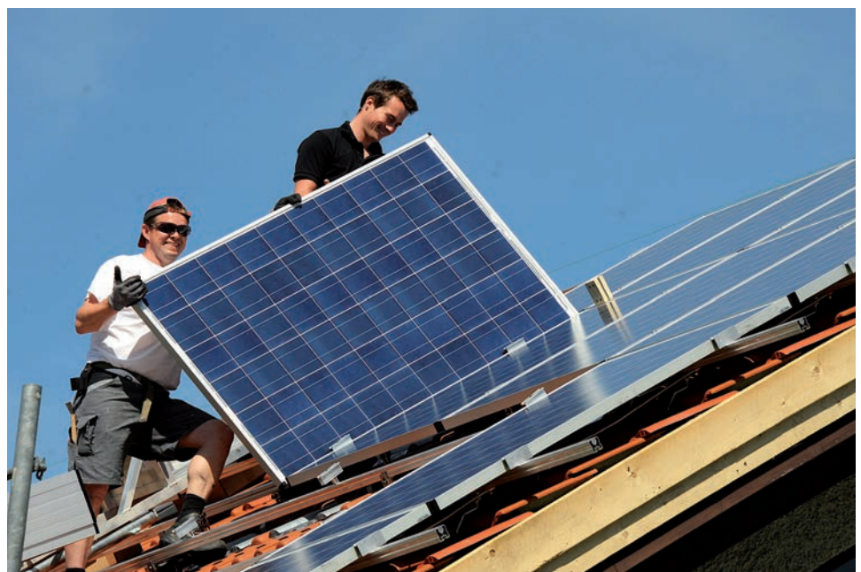
Photovoltaikmodule sind schnell am Dach montiert.
