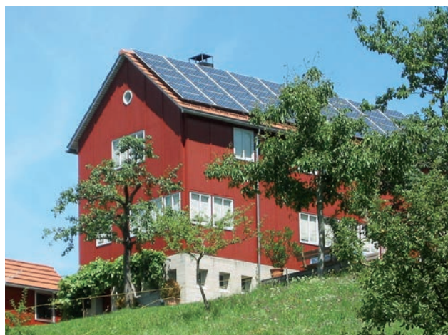
Zusammenhängende, rechteckige Fläche. Symmetrisch zur bestehenden Dachfläche.
