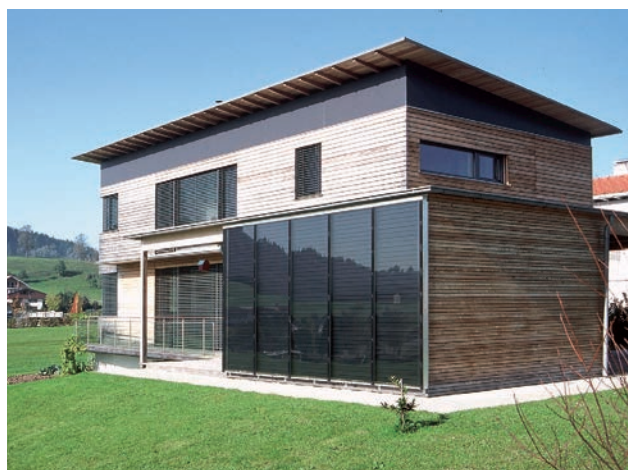
Gelungene Wandintegration im Nebengebäude.
