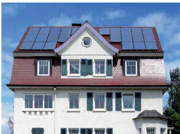
Die Kollektoren beeinträchtigen den Gesamteindruck.
