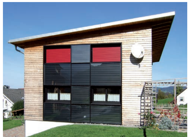
Thermische Kollektoren können in jeder Form und Größe gefertigt werden.
