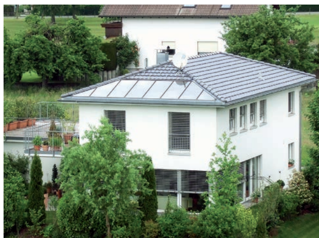
Unauffällige, dachintegrierte Lösung. Keine Investitionen in konstruktive Aufständigung.
