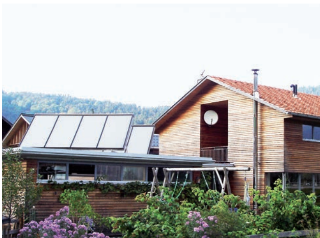
Die Orientierung der Kollektorfläche auf dem Pultdach gegen Süd bringt zwar rund 15 % Mehrertrag, beeinträchtigt jedoch das gestalterische Erscheinungsbild.
