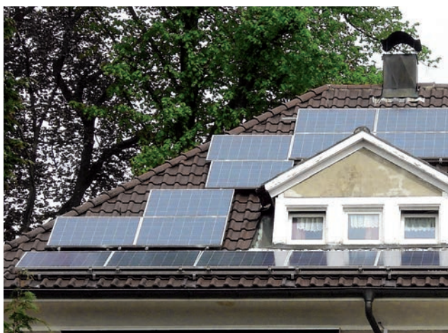
Getrepte Kollektoren beeinträchtigen die Dachform.
